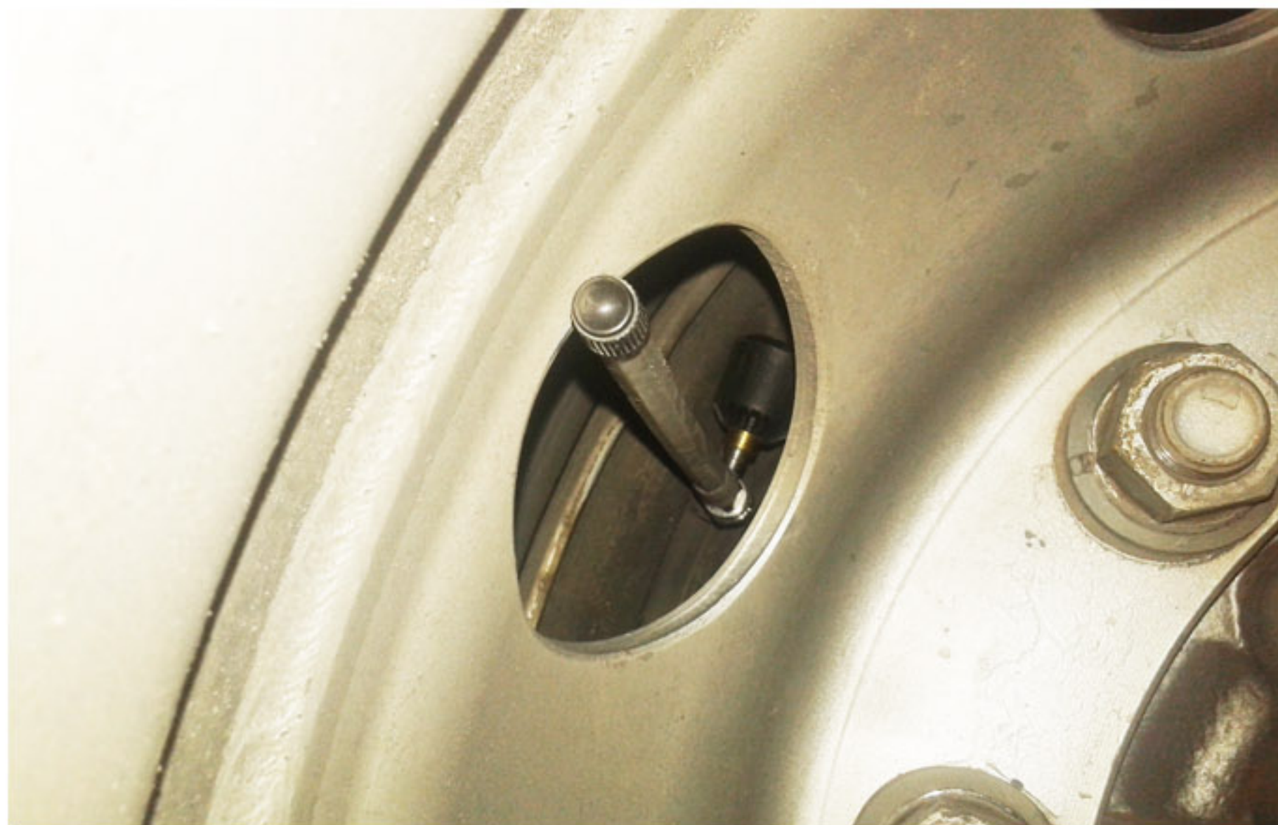
Датчик, тройник и удлинитель подкачки внутреннего колеса (вид на вентиль через отверстие внешнего диска)
